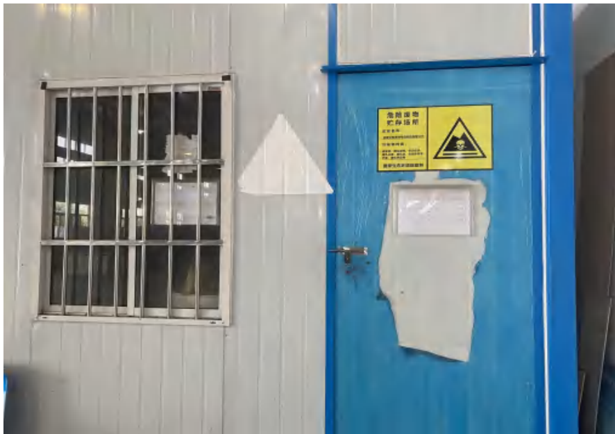
图 4 本项目危废暂存间现场图片
